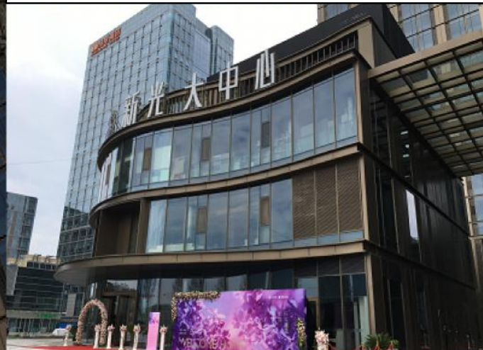
Actual site: Project showroom
